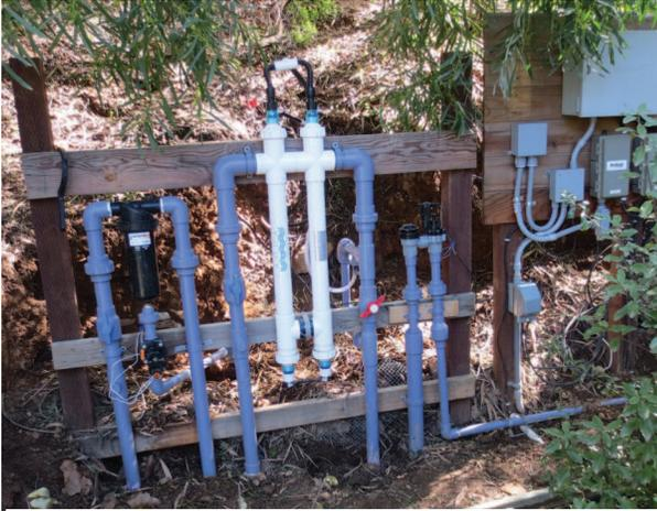
*Ejemplo de un sistema automatizado de riego por goteo con filtro. Foto: Leigh Jerrard.*
