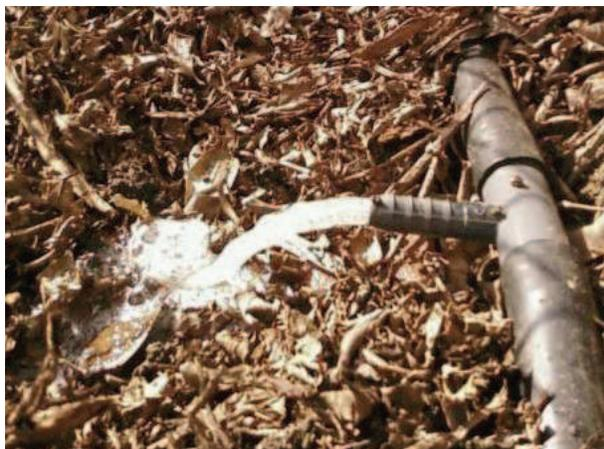
*Ejemplo de riego superficial: las aguas grises fluyen libremente sobre el mulch, que filtra el agua. Foto: Joe Linton.*
