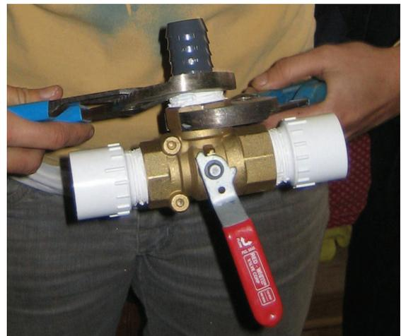
*Apretando las conexiones de la válvula de 3 vías con pinzas de extensión. Foto: Laura Allen*
