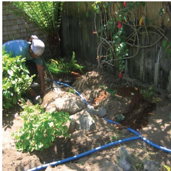
*La tubería de polietileno de alta densidad (HDPE) de 1 pulgada (25 mm) está colocada en las zanjas. Toda la tubería fue enterrada después de que se terminó de instalar el sistema. Foto: Laura Allen*
