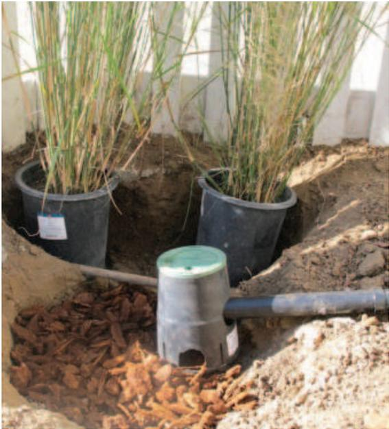
Usando una caja de válvula para riego subterránea.
