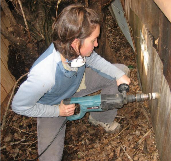
*Haciendo una perforación de 1.5 pulgadas (40 mm) para el tubo. Nota: Primero se taladro un orificio piloto. Foto: Laura Allen*
