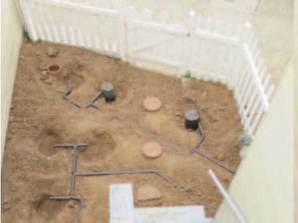
*Ejemplo de tuberías de aguas grises en un sistema de flujo por gravedad antes de que estuvieran enterradas.
