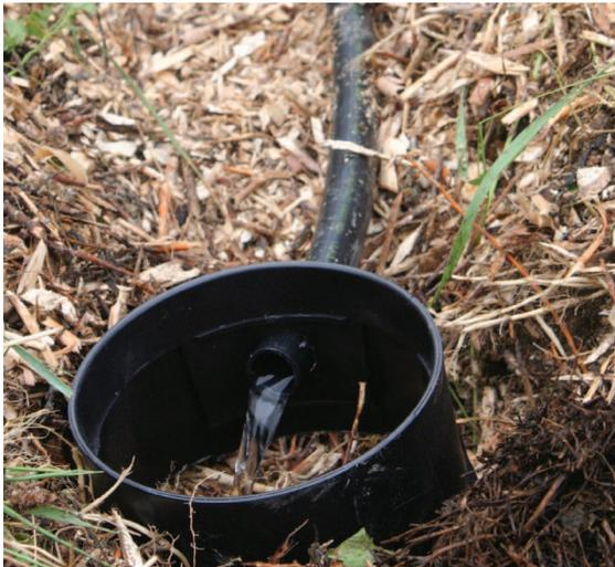
*Las aguas grises fluyen sobre el mulch. La salida está protegida de la intrusión de raíces por una cubierta de salida hecha con una caja de válvula. Una vez terminado, habrá una tapa sobre la cubierta de salida y la cuenca de mulch se rellenará. Foto: C. Eme.*
