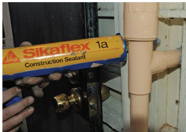
*Pinta la tubería de PVC que está expuesta al sol para protegerla de los rayos UV. La perforación se sella con un sellador adhesivo para evitar la entrada de la humedad.*
