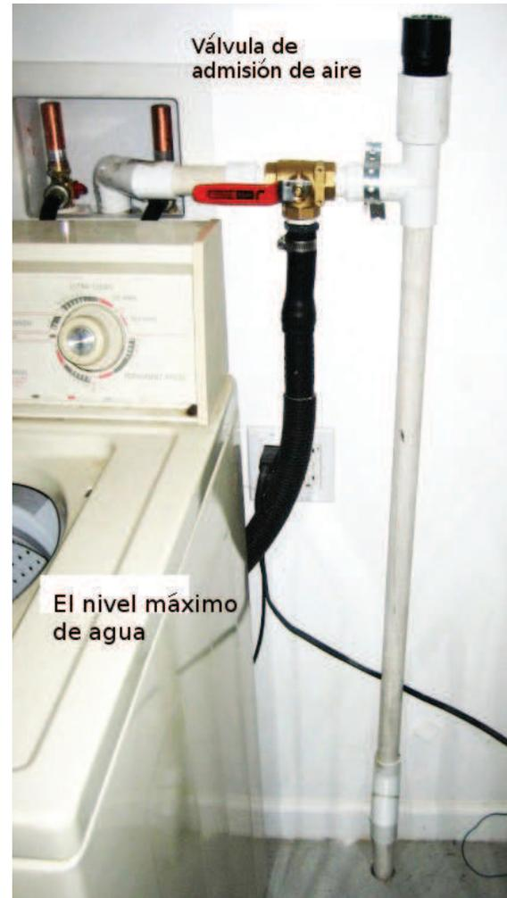
*La válvula de 3 vías es ligeramente superior a la conexión de alcantarillado (detrás de la máquina), mientras que la válvula de admisión de aire queda alrededor de un pie (30 cm) más alta que el nivel máximo de agua de la lavadora. Foto: Laura Allen*
