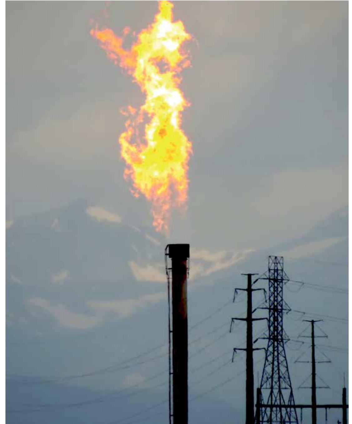
La combustión de gases —el quemado de metano— es una práctica común en las perforaciones en búsqueda de combustibles fósiles, el “fracking”, el refinado y procesado, lo cual genera importantes emisiones de dióxido de carbono, junto con otros contaminantes tóxicos. Los escapes y las
